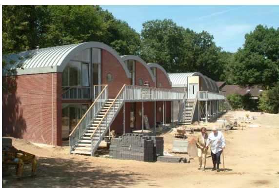
Woningen aan het Amberboomplein in aanbouw, 2005.
