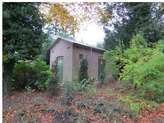
Trafohuisje van de PGEM aan de Graaf van Rechterenweg, vermoedelijk uit de jaren '50.
